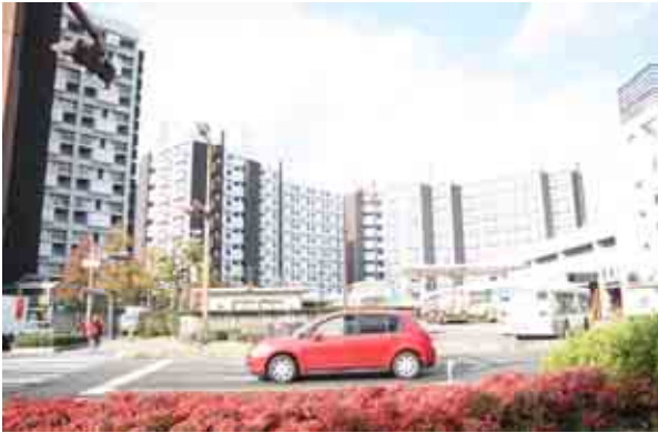
基町高層アパートの外観 (45° の角度をつけて「くの字」に配置)
