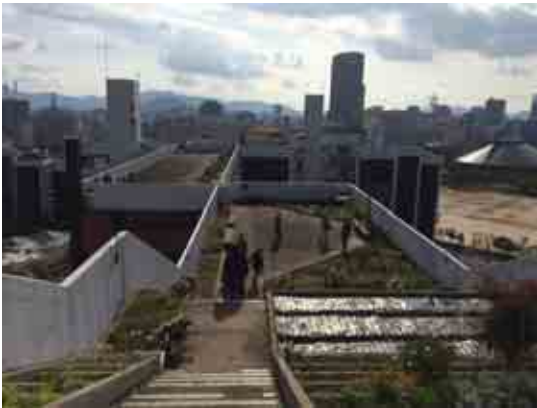
屋上庭園(普段は住民以外立入禁止)
