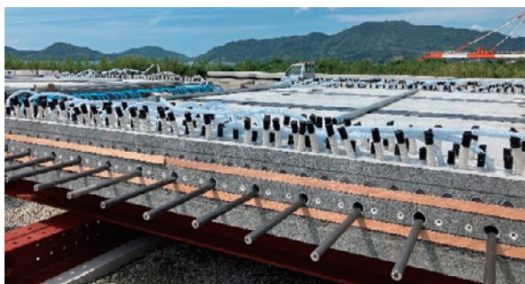
架設前の連続炭素繊維床版
