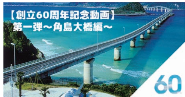
第1弾 角島大橋編(山口県) 奇跡を起こした角島大橋誕生秘話に迫る
