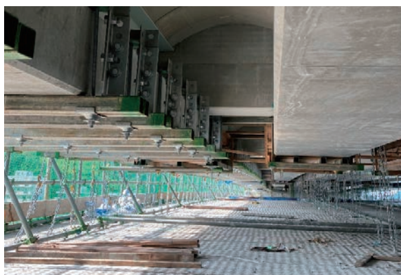
主桁下の様子
