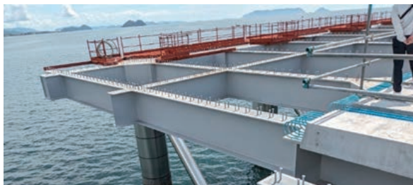
写真1 ジャケット栈橋現場
