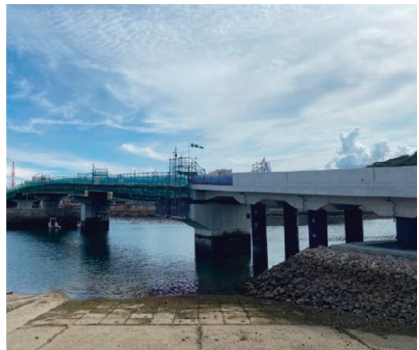
写真2 岩国港臨港道路 室の木線橋梁
