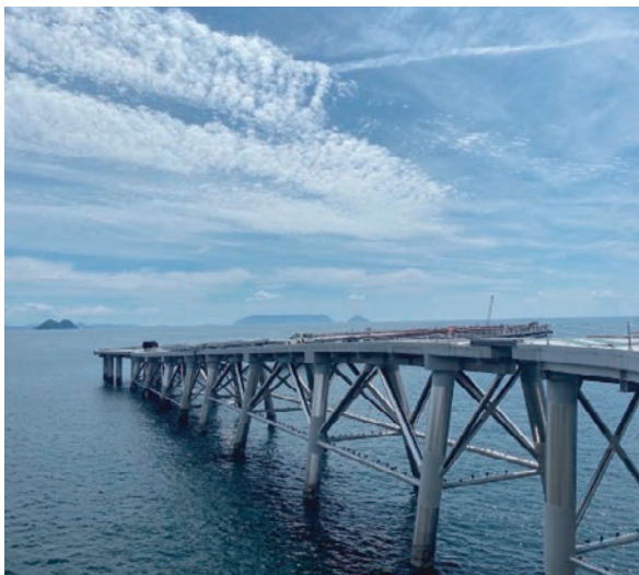
写真1 徳山下松港下松地区栈橋(-19m)
