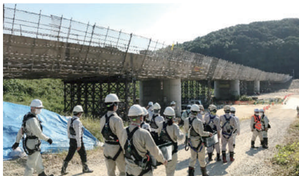
写真1 橋梁架設工事
