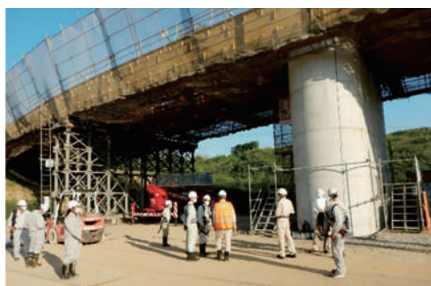
図2：架設した上部工を見学している様子
