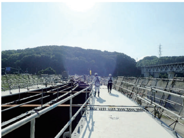
写真-1 鋼橋上部工
