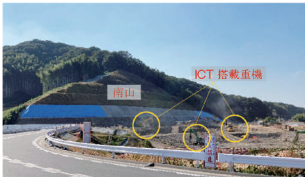
写真2 南山掘削工事
