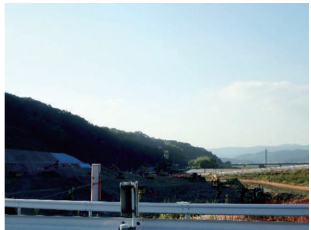
写真-2 南山掘削箇所
