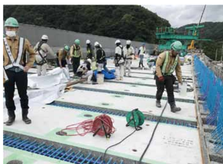
写真：床版取替工事現場
