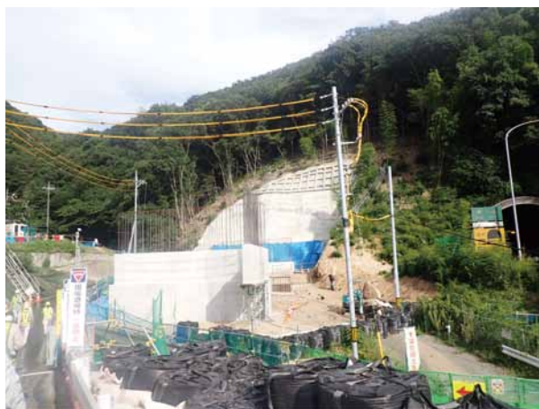
写真2 呉トンネル工事現場
