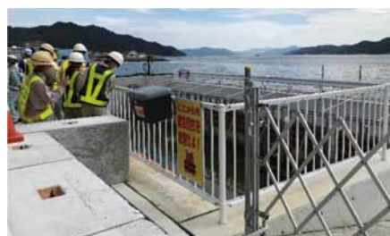
写真：土砂搬出場 沈砂池
