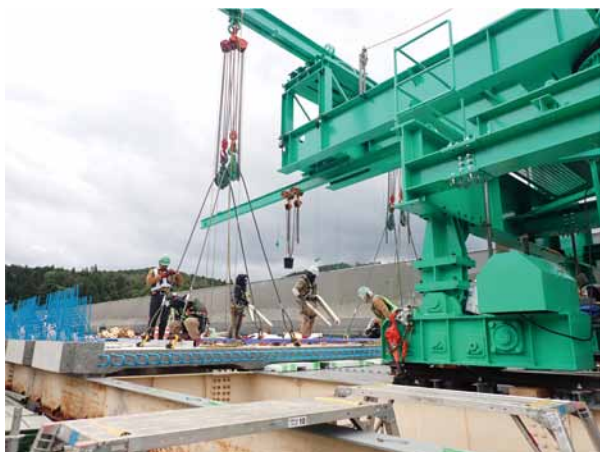
写真1 床版を架設する様子
