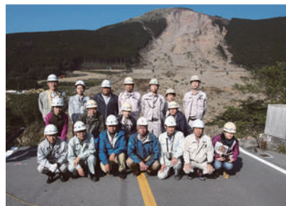
阿蘇大橋落橋現場
