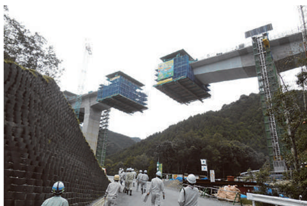
赤ノ谷橋上部工
