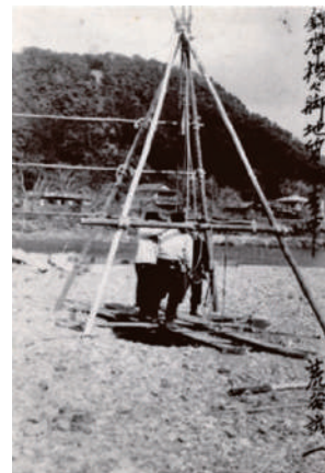
錦帯橋ボーリング
